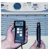
Kontrolle von Klima- anlagen
